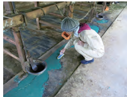
写真2 コテでレジンコンクリートを塗る様子
