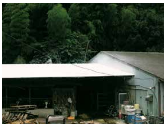
写真1 石灰塗布した牛舎屋根
