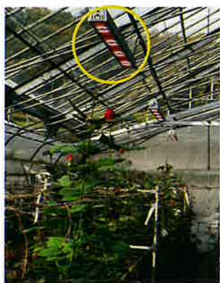
図1 補光機の設置状況 (○部は補光機)
