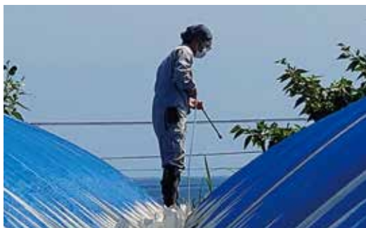
写真1 施設上部での遮熱剤塗布の様子
