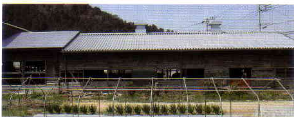
写真1 ガルバリウム鋼板使用の屋根（牛舎）
