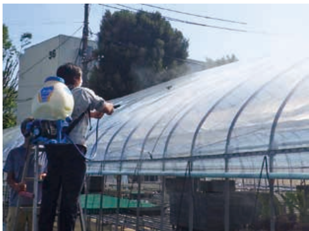
写真 遮熱塗料処理の様子
