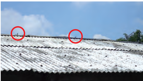
写真 屋根上のミストノズル（赤丸部分）
