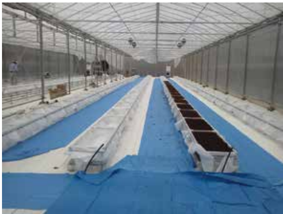
写真1 建設中の次世代アグリシステムハウス
