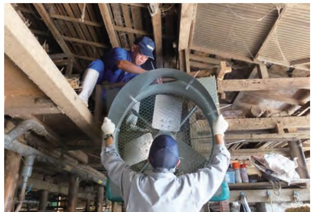
写真2 換気扇プレート設置作業
