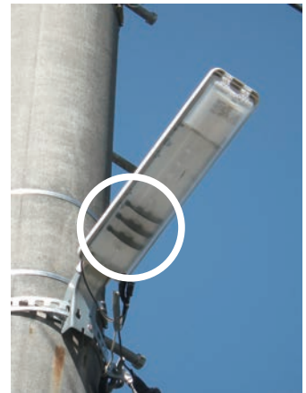
写真 遮蔽されたLED灯 (○内は遮蔽板)
