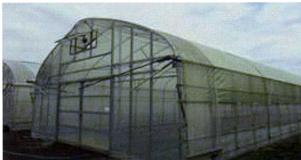
写真 資材を外張り被覆した施設の様子
