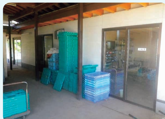
新東京都GAPの取組支援 整理整頓された作業場
