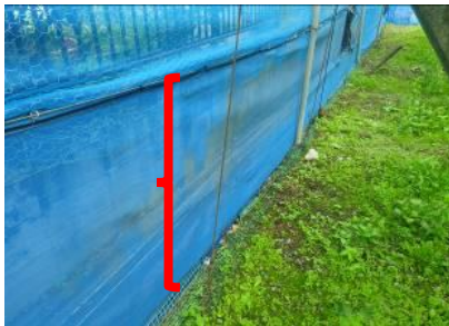
写真10 張り替えた防風ネット
