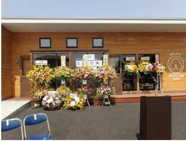
写真3 ジェラート加工場全景
