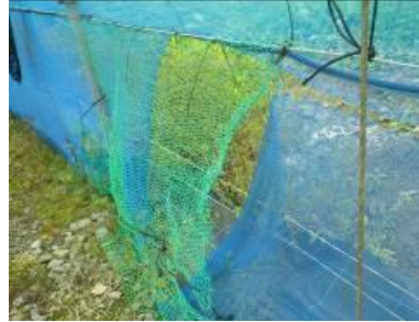
写真8 損傷の激しい防風ネット
