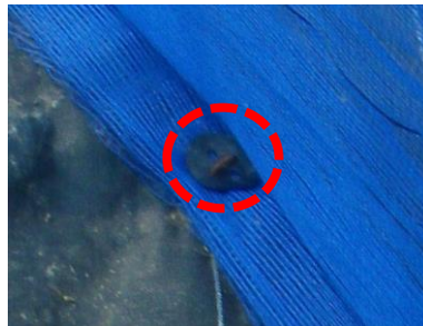
写真11 防風ネットの下端をU字杭で固定
