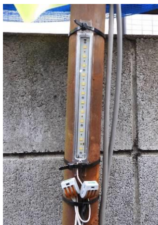
写真 1 支柱に設置した LED 機器
