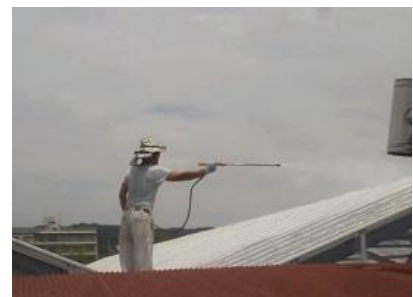
図3 塗布作業の様子
