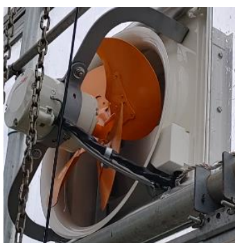
写真2 妻面に設置した換気扇 （3速式100V機種, Suiden社）
