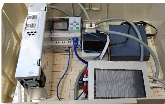
写真1 小型コンピュータによる制御盤
