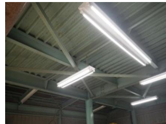
⑥照明の飛散防止設備の整備（飛散防止タイプの蛍光灯に変更）
